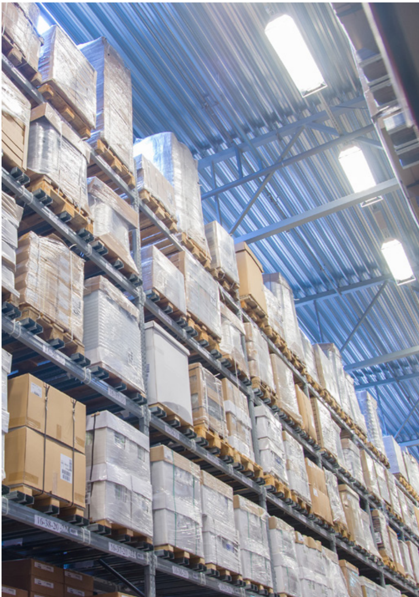
Utilisation de luminaires Industry 2 LED dans l'entrepôt
